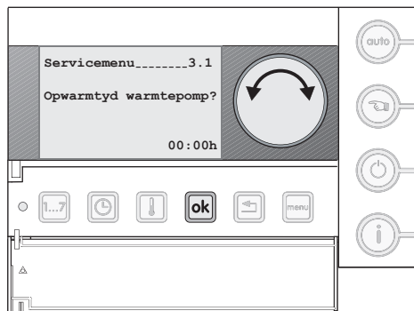
Afb. 48 Instellen opwarmtijd warmtepomp
